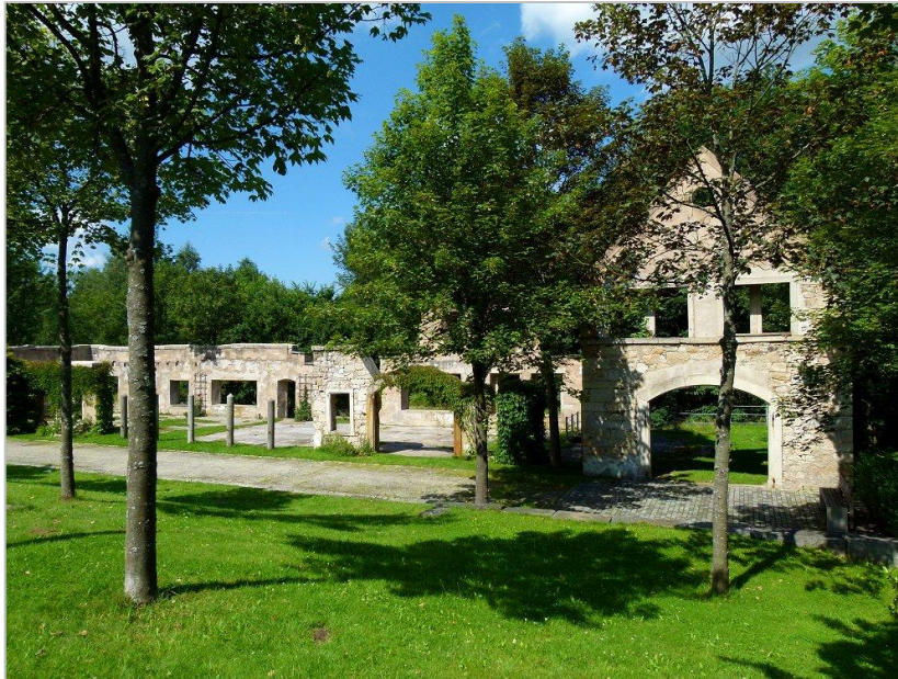
Abb. 7: Kulturpark Weißenstadt. Ehemaliges Gelände und Fabrikgebäude der GRASYMA. PURUCKER o.J.
